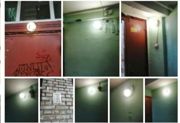
12.11.2021 Установка светильников НББ г. Пушкин, Ленинградская ул. 69 #жко2пушкин
