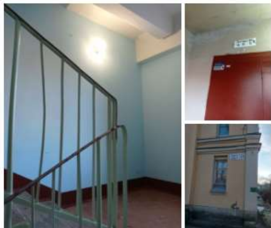
23.11.2021 Восстановление освещения г. Пушкин, Средняя ул. д. 13 #жкк2пушкин
