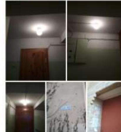
16.11.2021 Восстановление освещения г. Пушкин, Лавотьевское ул. 11 #жко2пушкин
