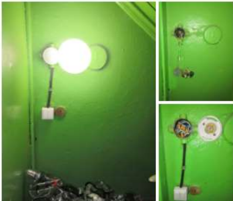
16.11.2021 Ремонт светильника #жко2пушкин
