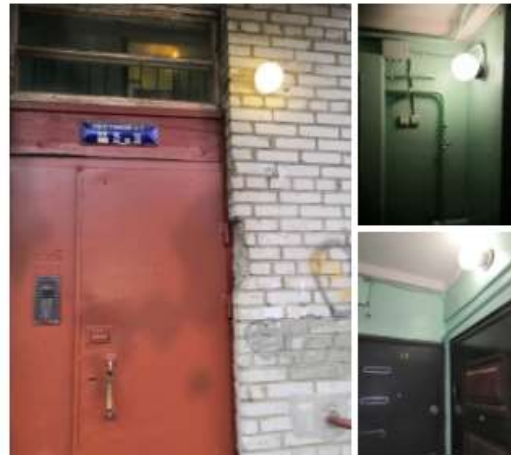
17.11.2021 Восстановление освещения г. Павловск, Динамо, Пионерская ул. 6 #жко2пушкин
