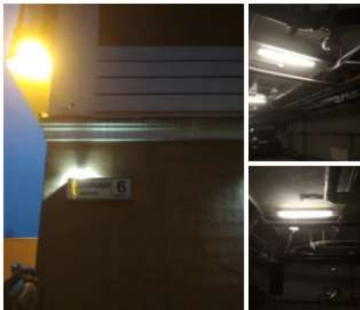
17.11.2021 Восстановление освещения в паркинге г. Пушкин, Колокольный пер. 6 к 2 #жкк2пушкин
