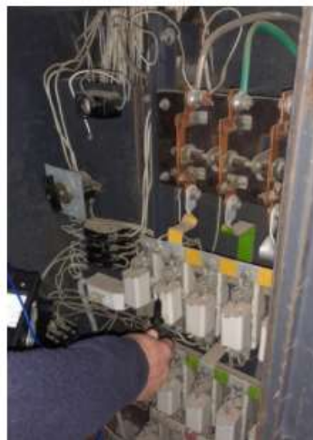
23.11.2021 Замер сопротивления изоляции г. Павловск, Динамо, Новая ул. д. 10 #жкк2пушкин
