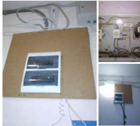
11.11.2021 г. Пушкин, Набережная ул. 10/61 Ремонт автоматов #жко2пушкин
