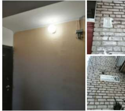
16.11.2021 Восстановление освещения г. Пушкин, Ленинградская ул. д. 63 #жко2пушкин
