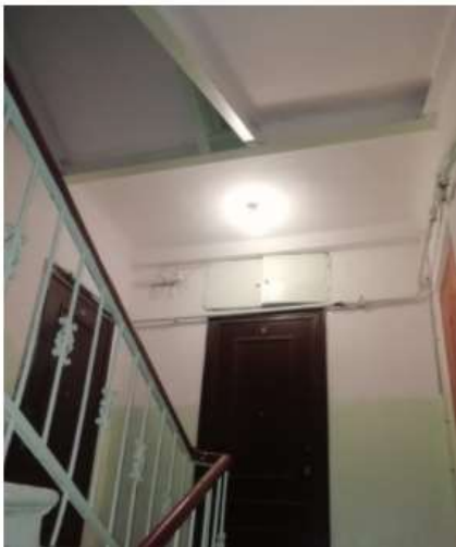
29.11.2021 Восстановление освещения г. Павловск, Конюшенная ул. 16/13 #жко2пушкин
