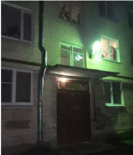
15.11.2021 Восстановление освещения г. Павловск, Конюшенная ул. 1 #жко2пушкин
