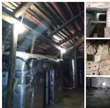
25.11.2021 Восстановление освещения в подвальном помещении. Ремонт выключателя. г. Пушкин, Оранжевая ул. 67/31 #жкк1пушкин
