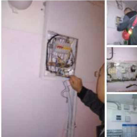
15.11.2021 Замер изоляции г. Пушкин, Набережная ул. 10/61 #жко2пушкин
