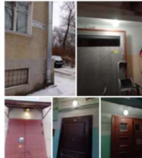
29.11.2021 Восстановление освещения г. Пушкин, Сдростовая ул. 10 #жко2пушкин
