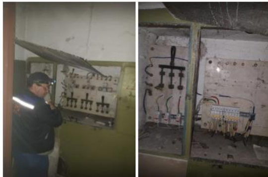
12.08.2021 Ремонт ГРЩ г. Пушкин, Октябрьский б-р. 19 #жкк2пушкин
