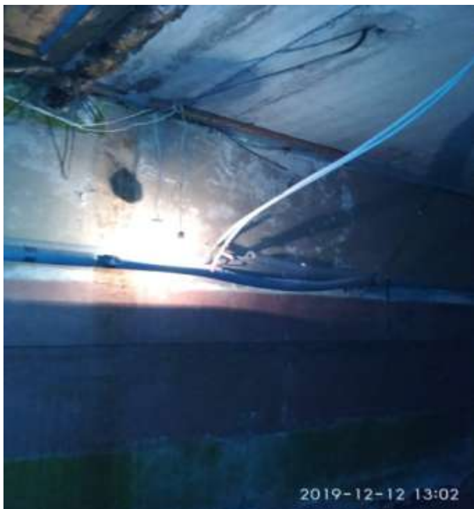
СПб, г. Пушкин, ул. Оранжерейная, д.39, лит.А Выполнение работ по восстановлению освещения в подвальном помещении
