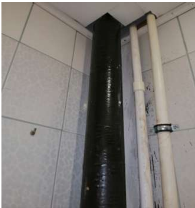
СПб, г. Пушкин, ул. Оранжерейная, д.39, лит.А Выполнение работ по замене стояка в кв. 3, 7
